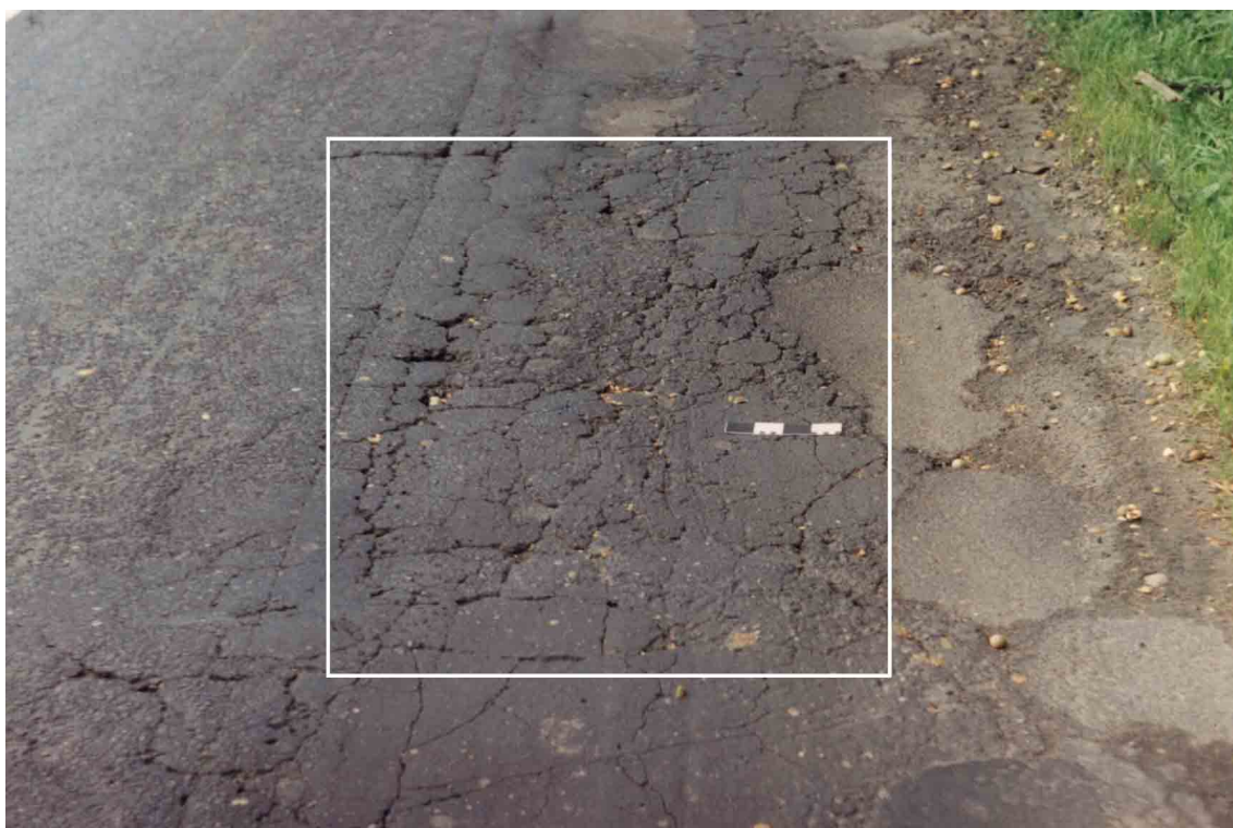
Fot. 4. Obserwuje się bardzo dużą gęstość pęknięć, luźne fragmenty i znaczne wykruszenia. Długość wzorca 20 cm.
