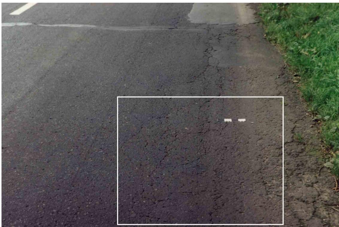
Fot. 1. Widoczne pęknięcia mają zmieniającą się szkodliwość, dalej za wyróżnionym obszarem wykruszenia sprawiają, że pęknięcia kwalifikuje się do dużej szkodliwości. Długość wzorca 20 cm.
