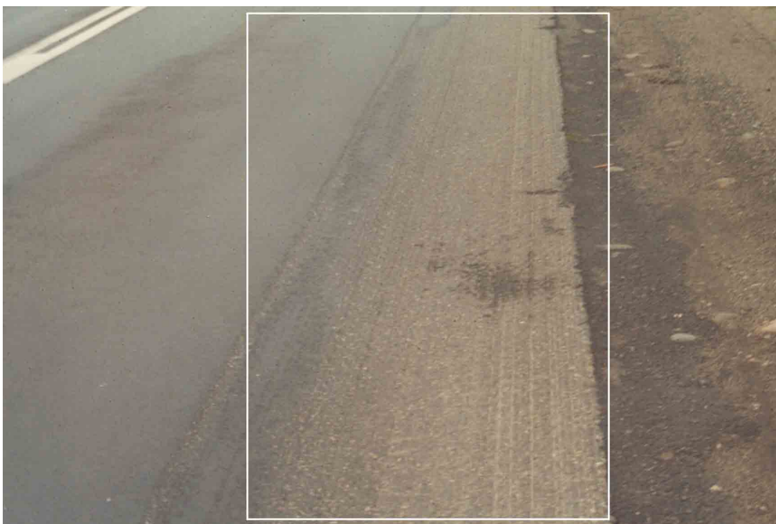
Fot. 43. Część pasa ruchu jest sfrezowana.
