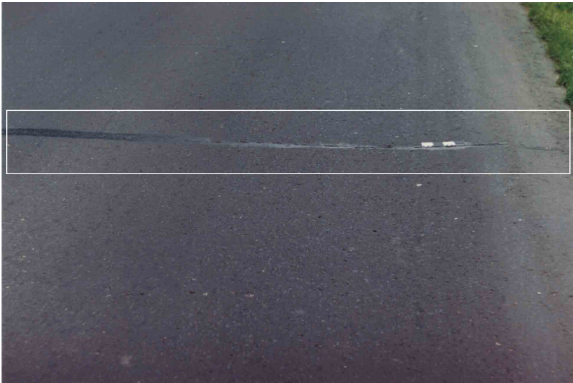
Fot. 21. Pęknięcie było zalane jednak w wielu miejscach ponownie utraciło szczelność. Długość wzorca 20 cm.
